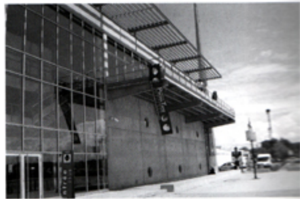
Photo 1. L'entrée du bâtiment de Cap Sciences (cliché Gérard Sustrac).
