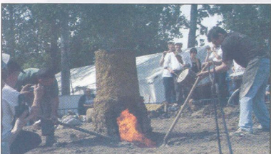
Un moment très attendu et spectaculaire : l'ouverture du bas-fourneau, l'appartenance de la lave en fusion et l'extraction de la « loupe » ferreuse.
