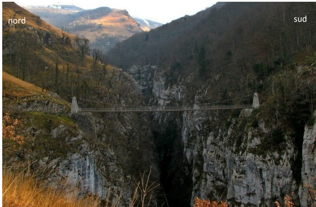
Le canyon d'Olhadubi est enjambé par la passerelle d'Holzarté. La rivière coule actuellement 120 m sous le pont (site 1).
