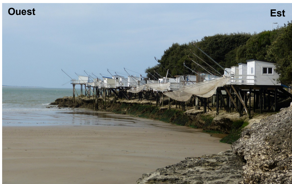
Carrelets ancrés sur les calcaires dans la Conche de Pontaillac (45° 62538 N – 1°05619 O )
